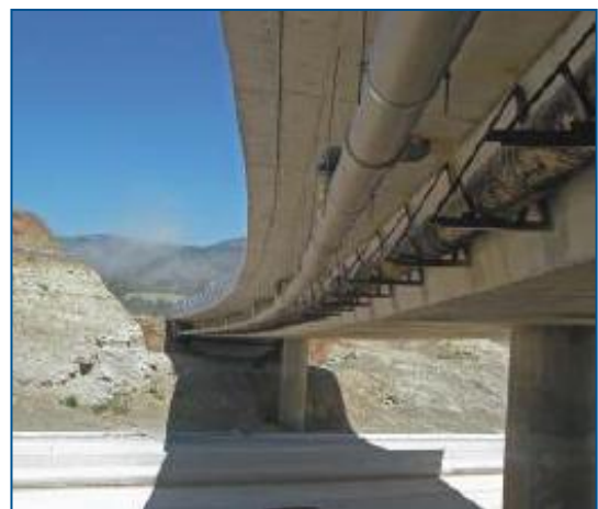
Εγνατία Οδός: Γέφυρα Αλιάκμονα
